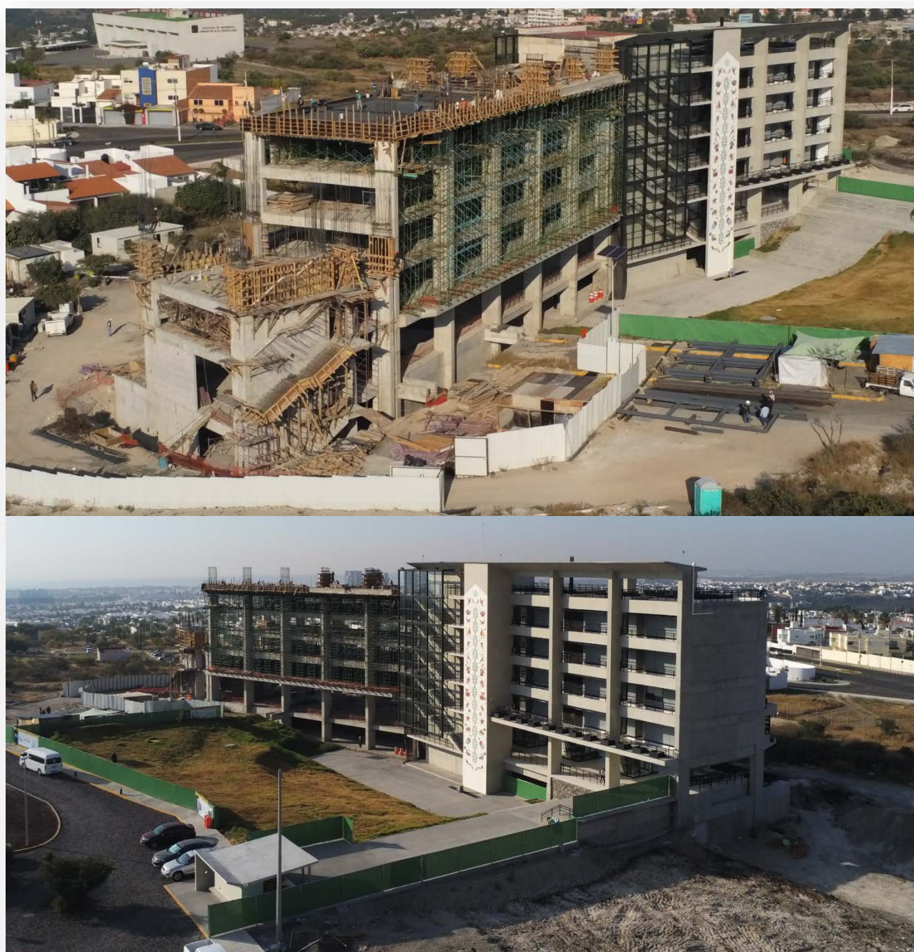
Foto 67. Avance de la construcción de los edificios de la ENES Juriquilla, diciembre 2019
