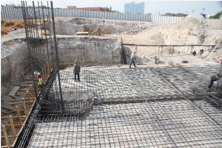
Foto 63. Inicia colado de zapatas en Edif. IV
