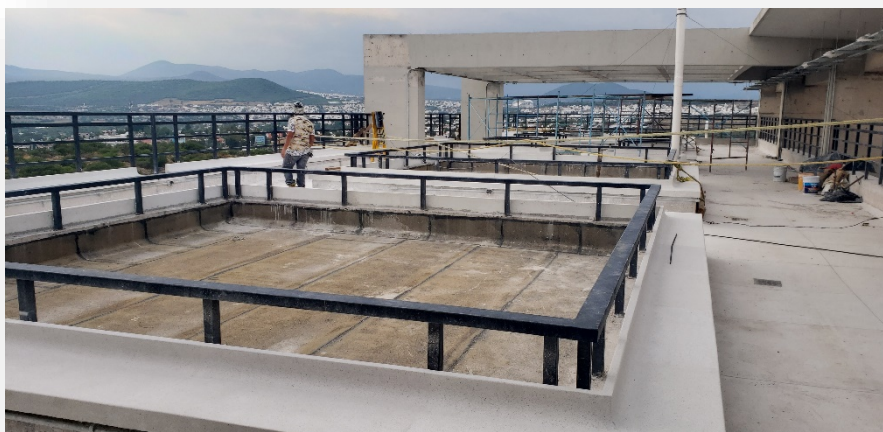
Foto 50. Terraza en 5to. Piso del Edif. V
