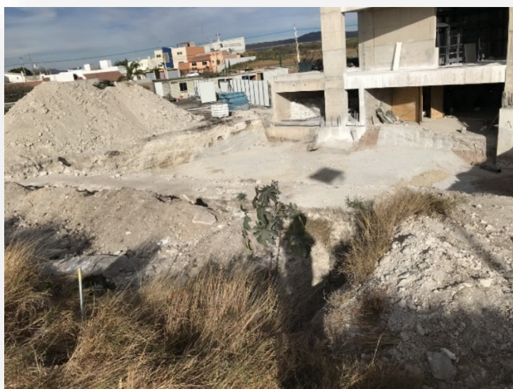
Foto 66. Cimientos de estructura de sanitarios de Edif. III
