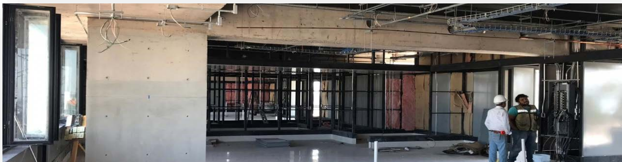
Foto 51. Trabajos internos, Edif. V
