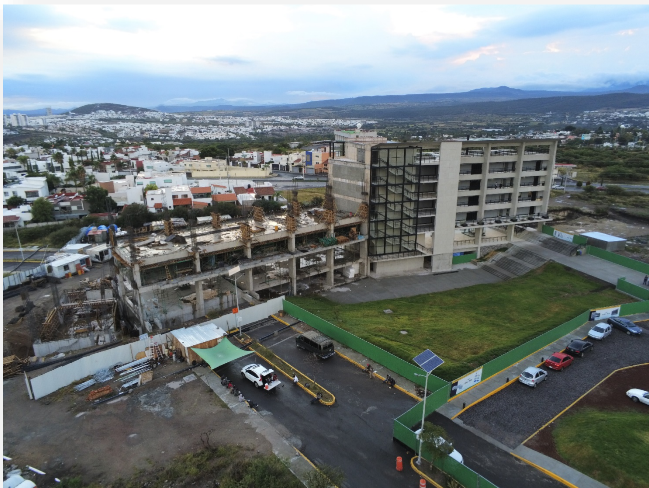
Foto 65. septiembre 2019, avance en edificio IV y avance en cimientos de núcleo de sanitarios edificio III
