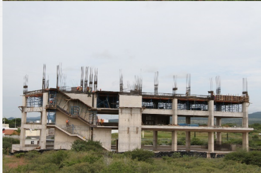
Foto 47. Agosto 2018 avance en obra Edif. V
