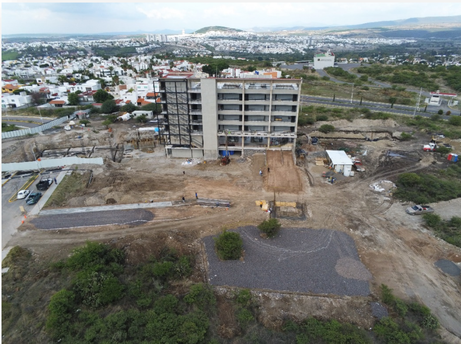
Foto 64. Comienza obra exterior Edificio IV, junio 2019
