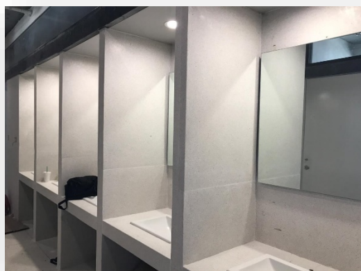
Foto 54. Núcleo de sanitarios, Edif. V ENES Juriquilla
