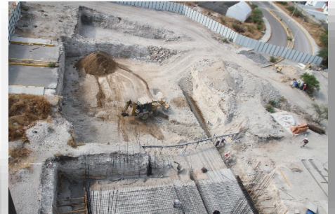
Foto 61. Excavación para cimientos del Edif. IV
