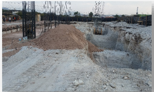
Foto 49. Febrero 2018, excavación para cimientos Edif. V, ENES Juriquilla
