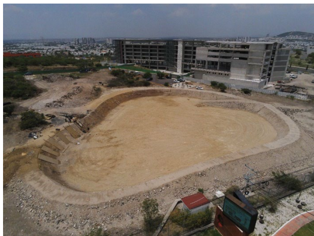
Foto 7 Trabajos para construcción del vaso recolector de agua pluvial
