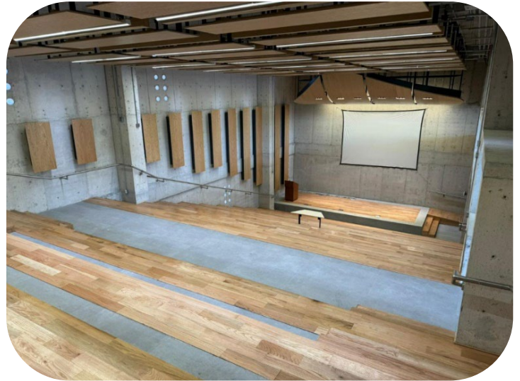
En agosto se terminaron las instalaciones y en septiembre se inauguró el Foro del edificio III.
