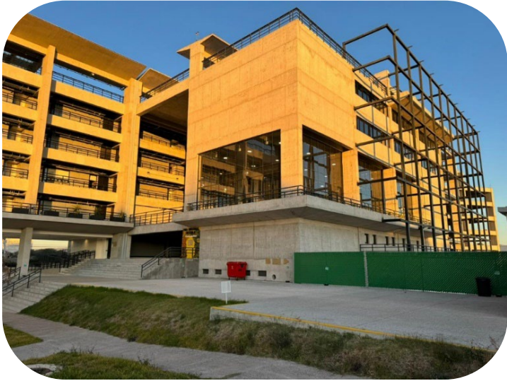
En agosto se terminaron las instalaciones y en septiembre se inauguró el Centro de información Digital del edificio VI.
