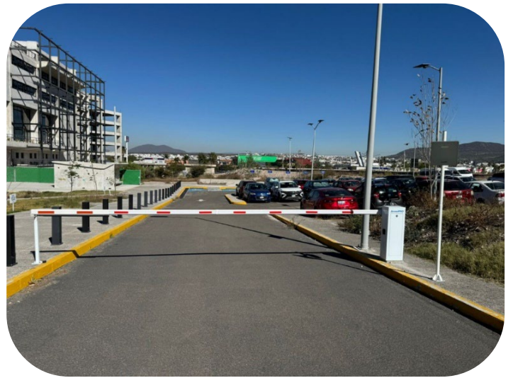
En enero se instaló la barrera vehicular en el estacionamiento
